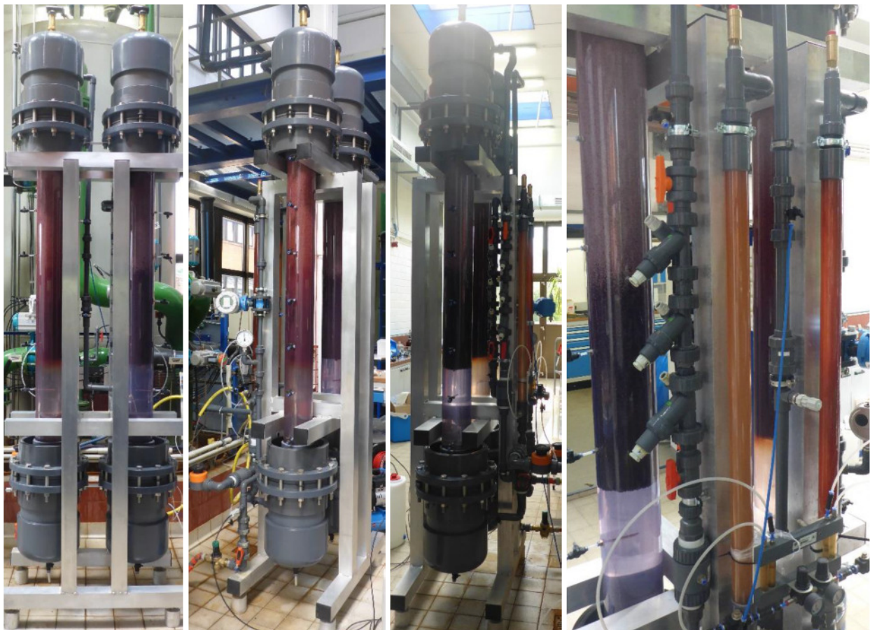
Abbildung 6: Fotos der Anlage von links nach rechts: Frontalansicht, schräg links vorne, schräg rechts hinten, hinten mit Belüftungsreaktoren
